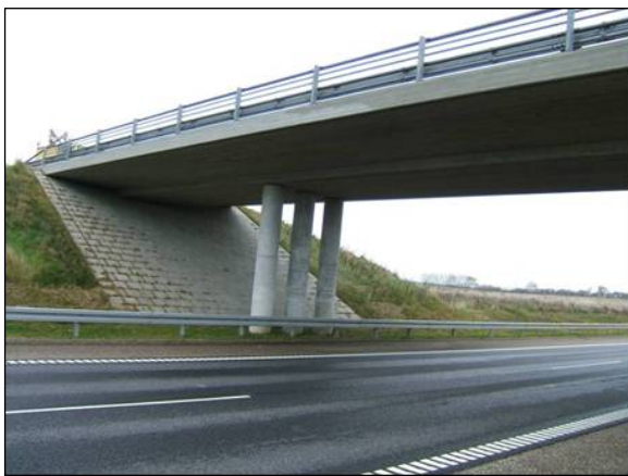
Figur 1. Billedet viser en del af Demobroens vestside. På kantbjælken ses støbeskellet mellem to betontyper som en nuanceforskel. Der er referencebeton til højre og flyveaskebeton til venstre for støbeskellet. De 3 bropillere er støbt med hver sin betontype.
